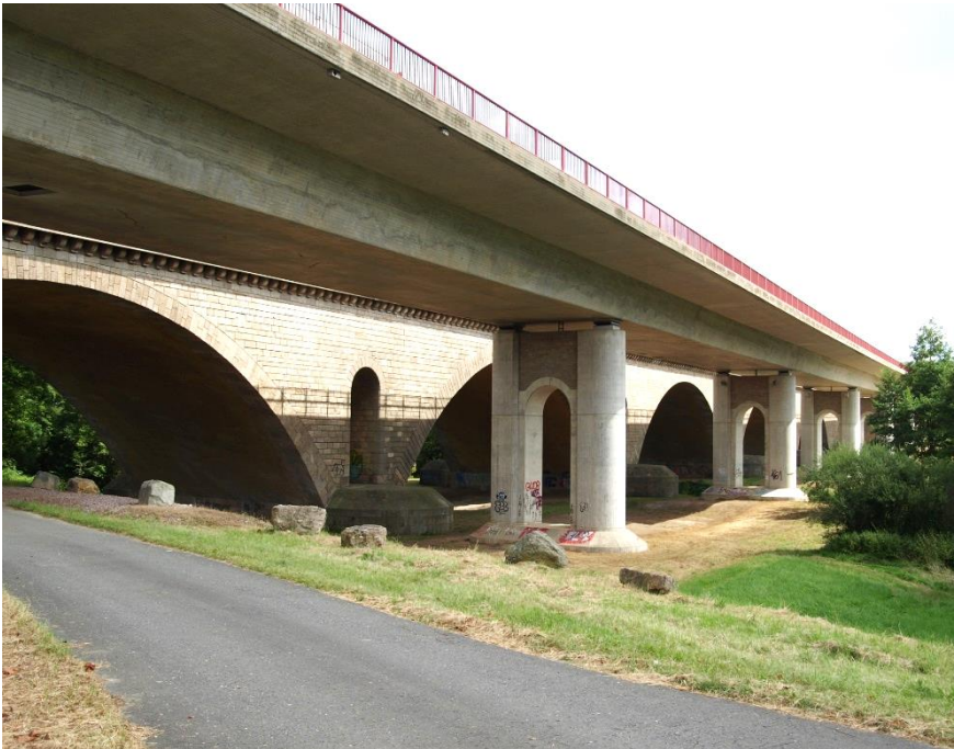
Bild: Ilmtalbrücke der BAB 4 bei Mellingen Foto: Joachim Neubert
