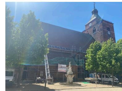
Auch an St. Nicolai in Osterburg wird weiter gebaut. Die Sanierungsarbeiten an der Nordfassade gehen gut voran. Die Installation der Dachrinne läuft parallel zu den Maurerarbeiten und zur Fenstersanierung. Ebenfalls parallel laufen die Vorbereitungen für den nächsten Bauabschnitt: den barrierefreien Zugang und die Installation einer Kinderkirche und einer WC-Anlage.
