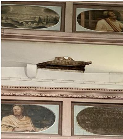
In Großenlupnitz wurden 2023 Sondierungsarbeiten zur Dachsanierung durchgeführt. Dabei fiel leider der Putz von der Decke der 1. Empore. Die Dielung ist im Laufe der Zeit weggefault. Demzufolge muss die Empore bis auf Weiteres gesperrt bleiben!
